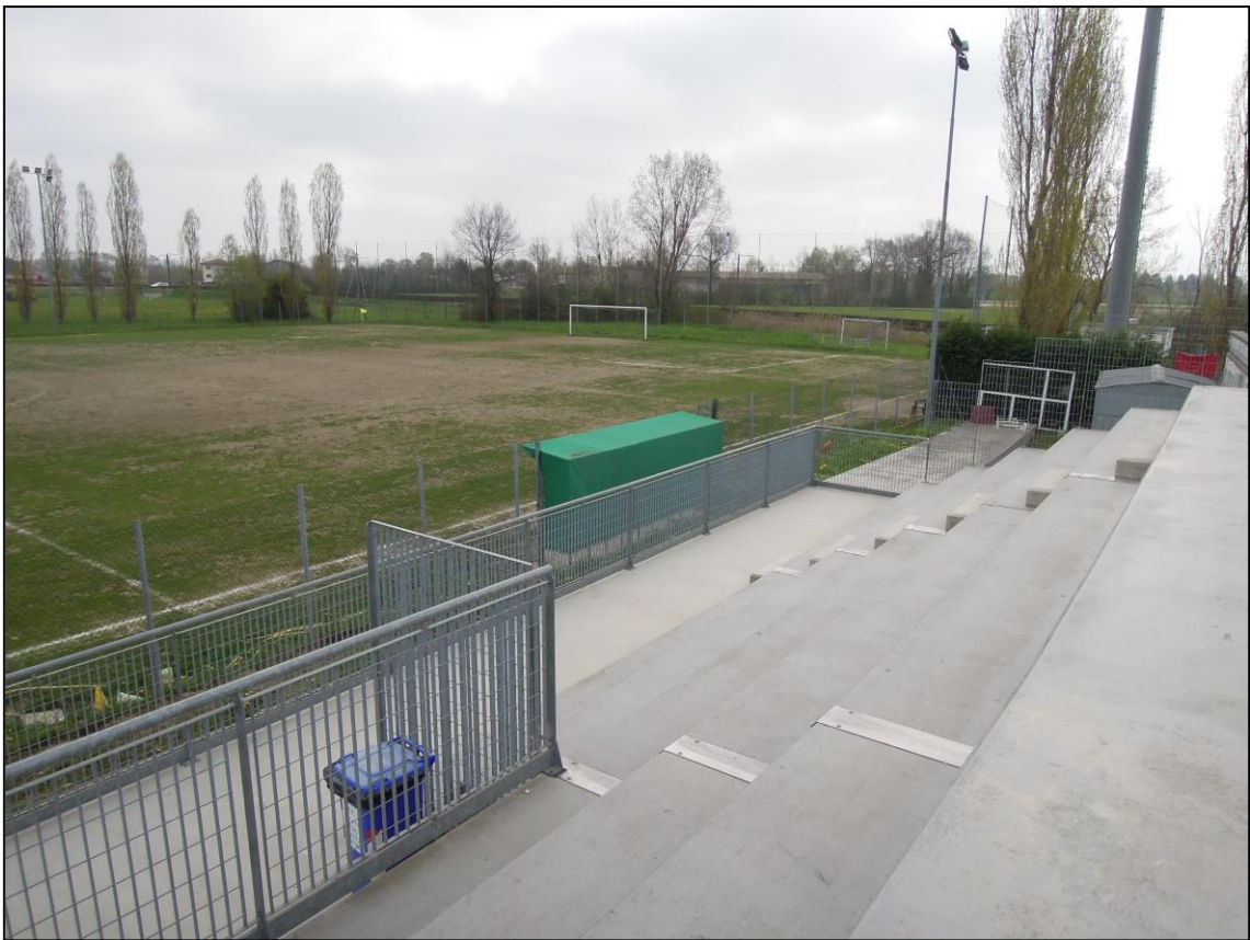
1-2- Vista del campo dalle gradonate
