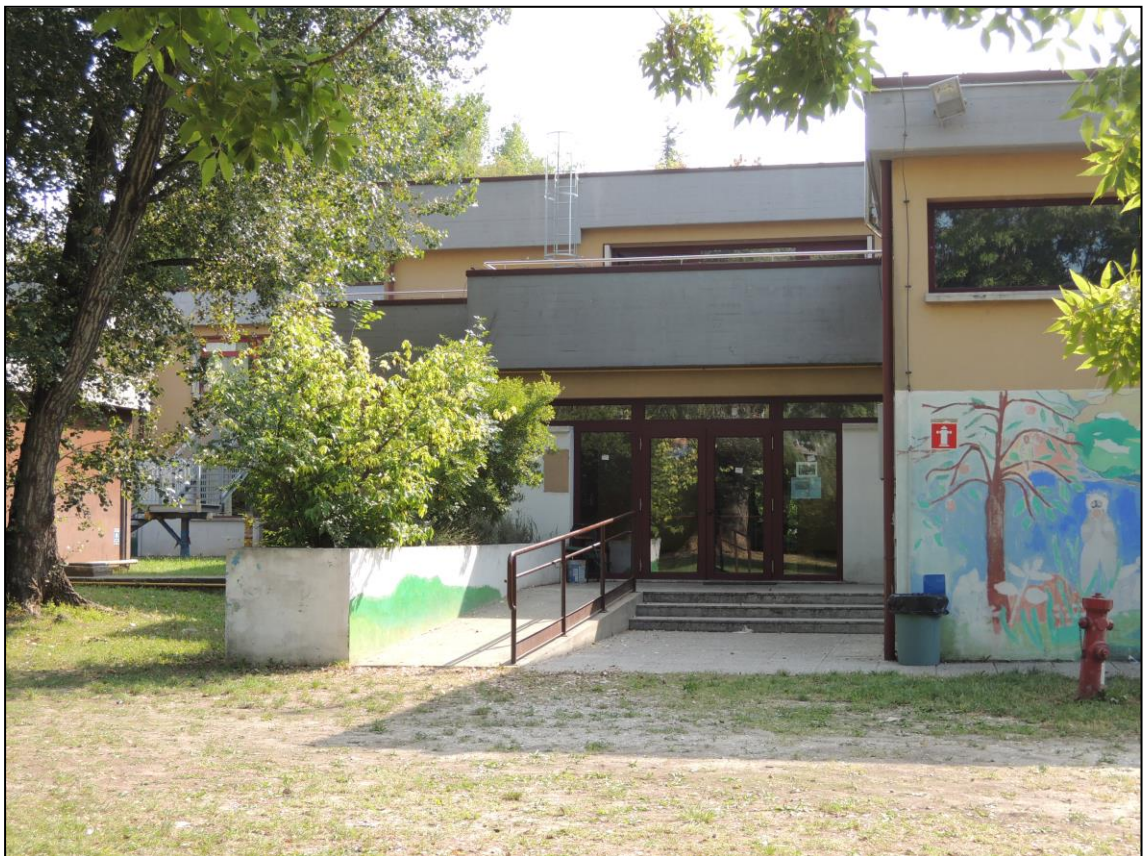
1- Ingresso esterno alla palestra
