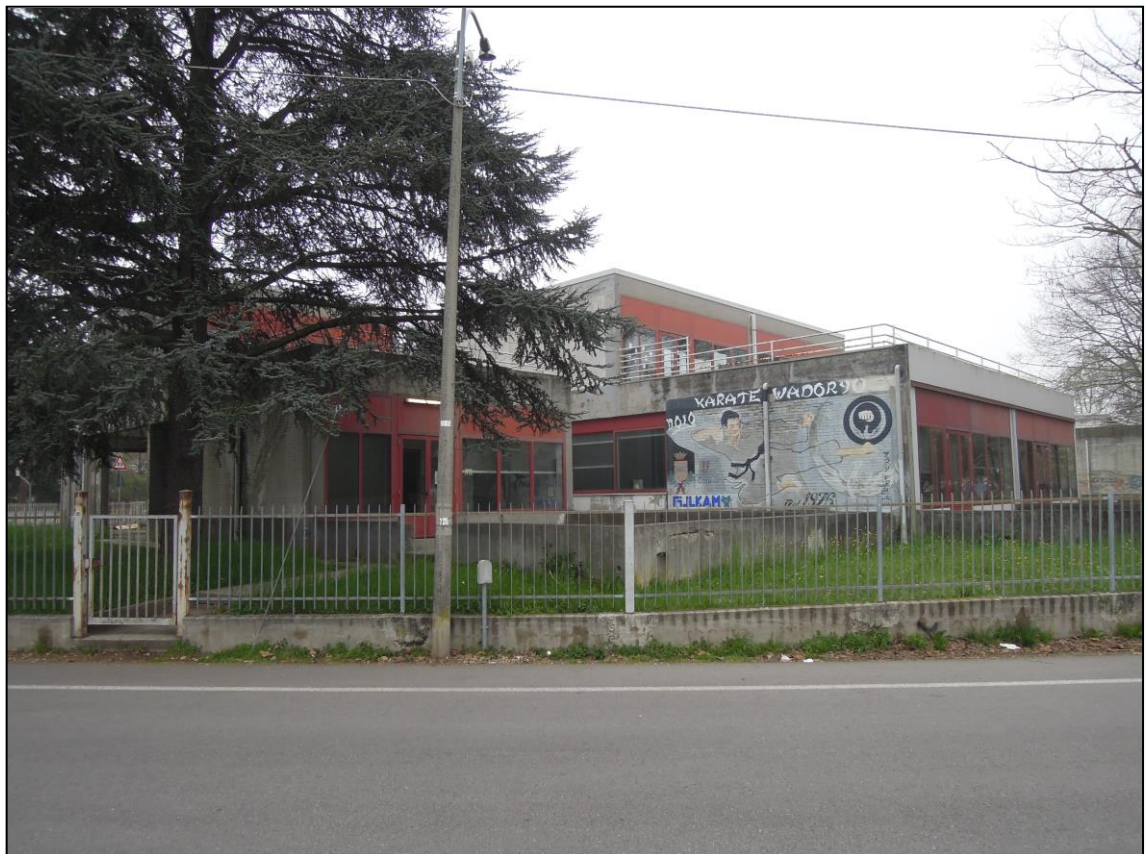
1- Ingresso esterno alla palestra
