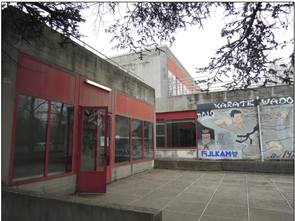
2-3 Ingresso esterno alla palestra
