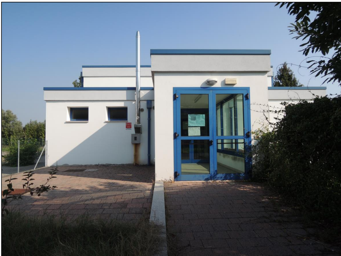
2- Ingresso esterno alla palestra
